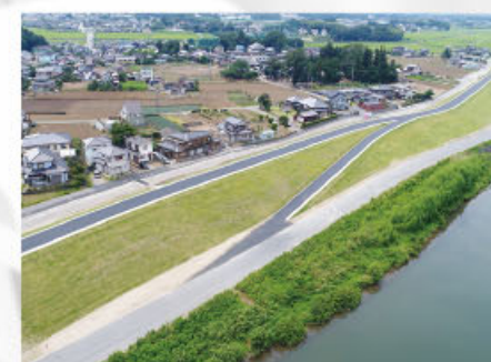
● H29 鬼怒川右岸向石下築堤工事 令和元年07月 下館河川事務所表彰
