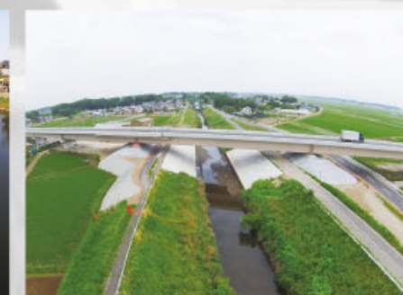
● 圏央道内野山地区改良(6)他工事 令和元年07月 北首都国道事務所表彰
