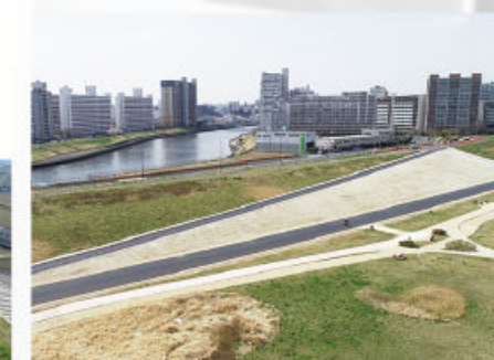
● H29 荒川右岸新田3丁目坂路整備工事 令和元年07月 荒川下流河川事務所表彰
