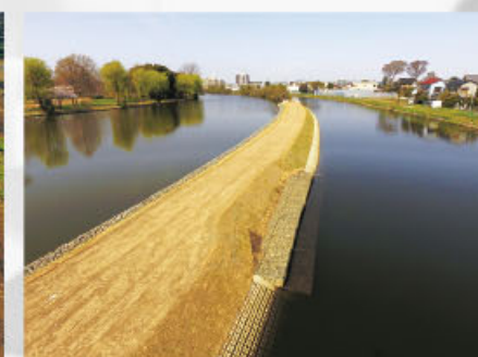
● 8041 河川改修工事(堤防修繕工) 令和元年12月 埼玉県越谷県土整備事務所表彰
