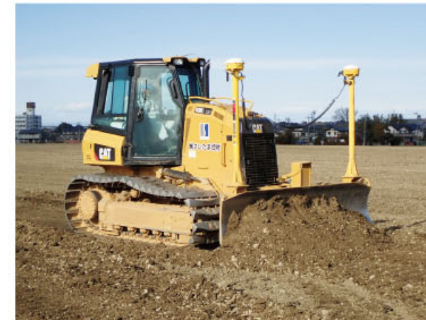
● R1 荒川右岸三保谷宿災害復旧工事
