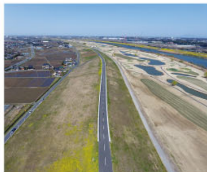
● R1 江戸川右岸金杉地先堤防整備他工事 令和3年7月 江戸川河川事務所表彰
