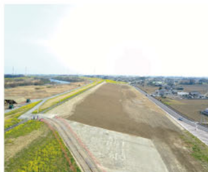
● H29 惣新田地区堤防整備工事 令和元年11月 江戸川河川事務所表彰
