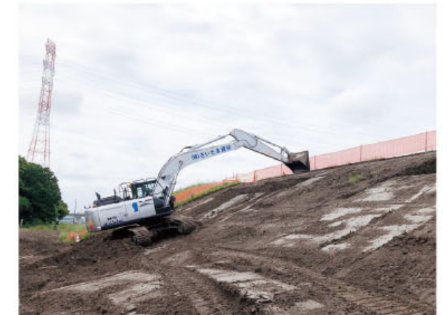
● H30 荒川西区西遊馬地区河川防災ステーション整備他工事
